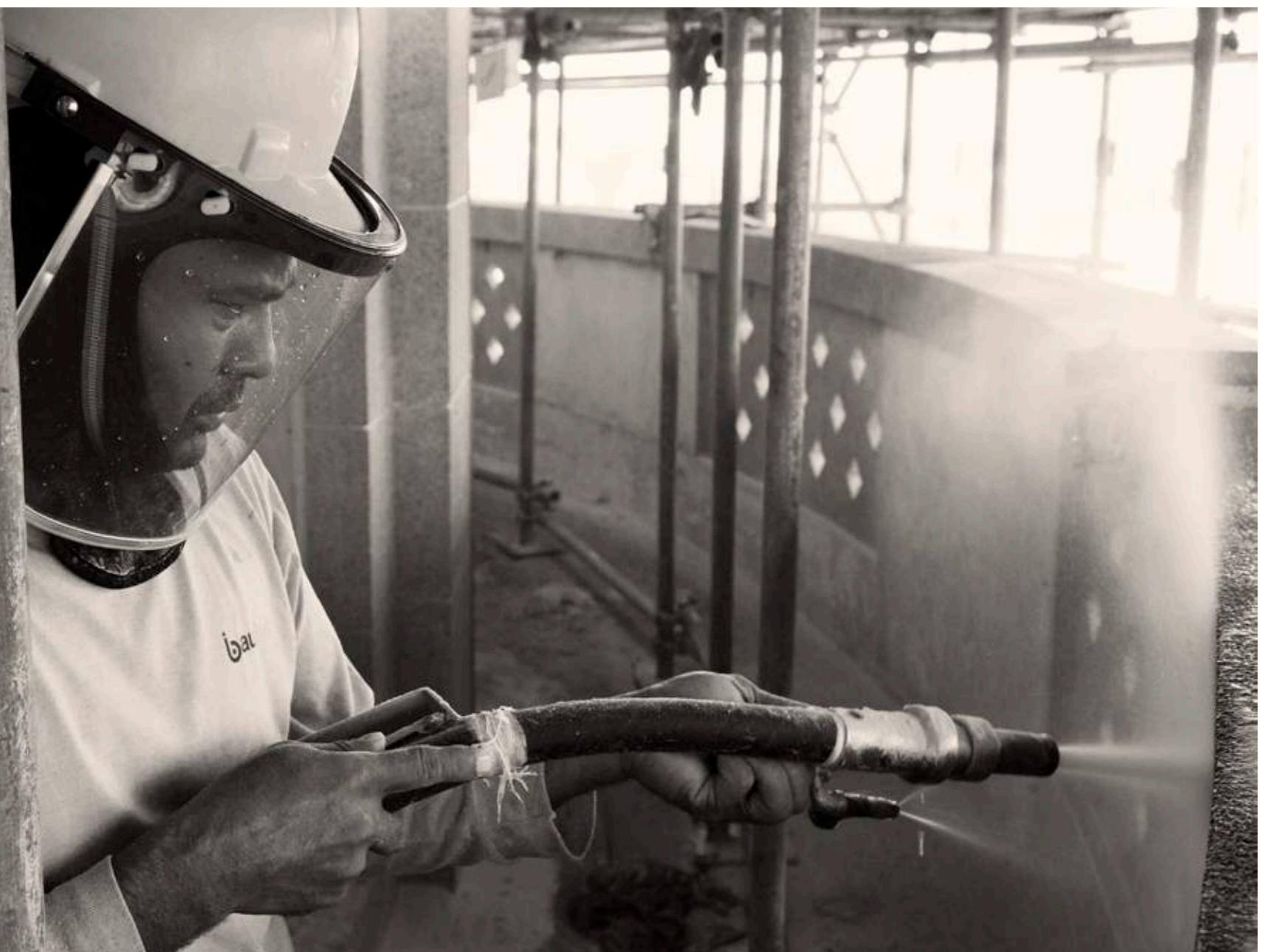
Nettoyage du béton granitique de la façade à l'eau, 2012
