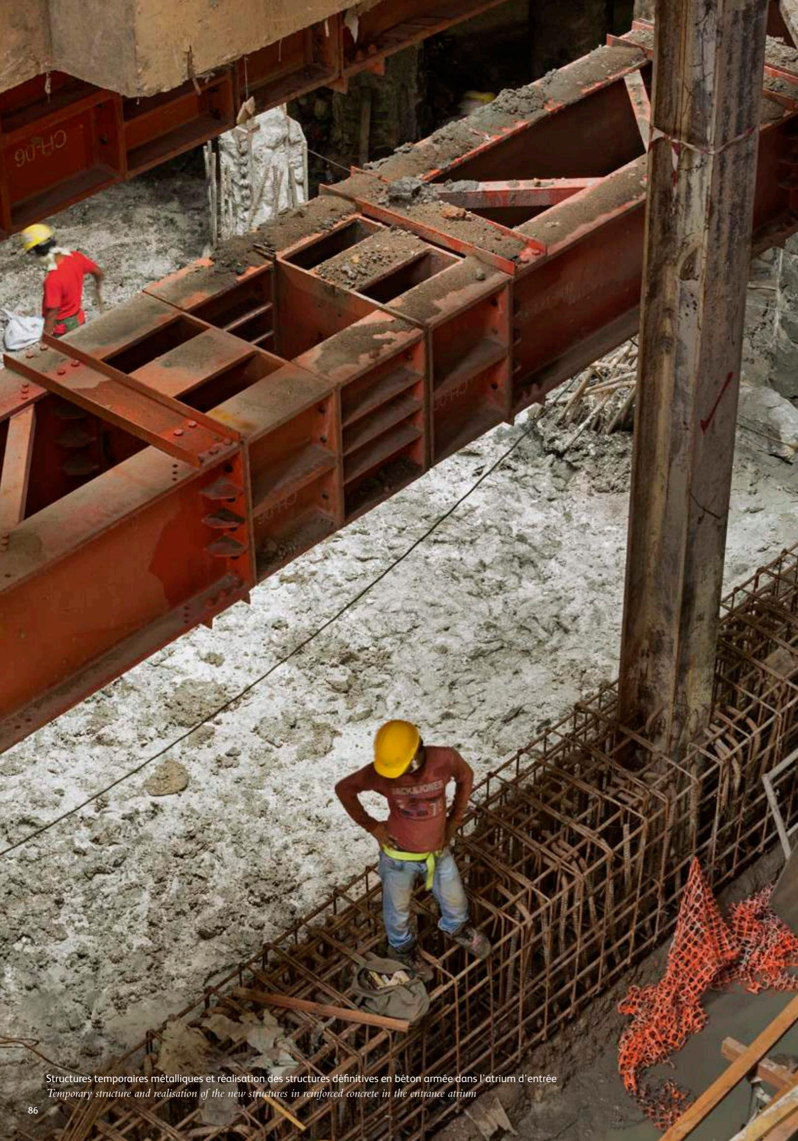
Structures temporaires métalliques et réalisation des structures définitives en béton armé dans l'atrium d'entrée
