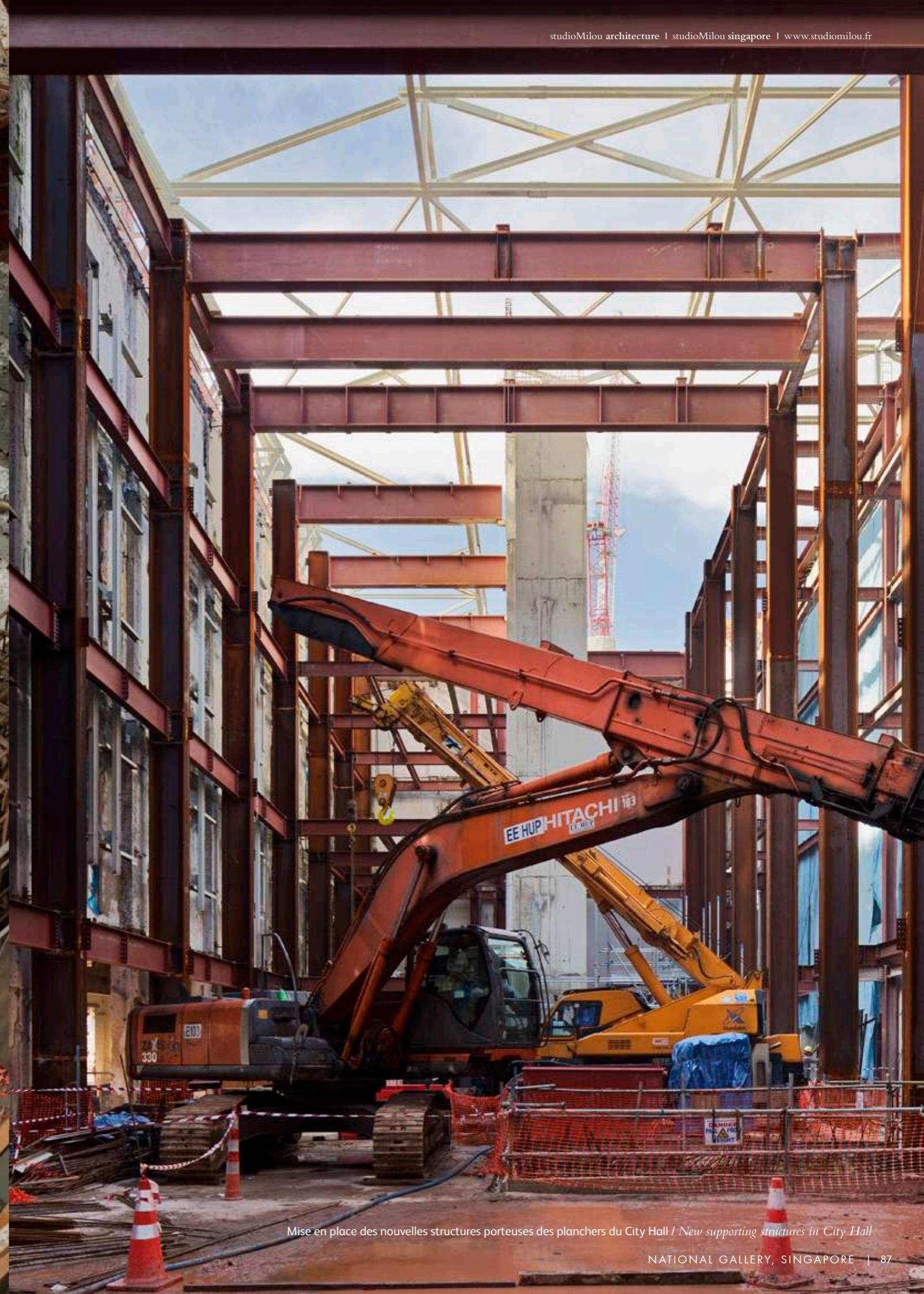
Mise en place des nouvelles structures porteuses des planchers du City Hall / New supporting structures in City Hall
